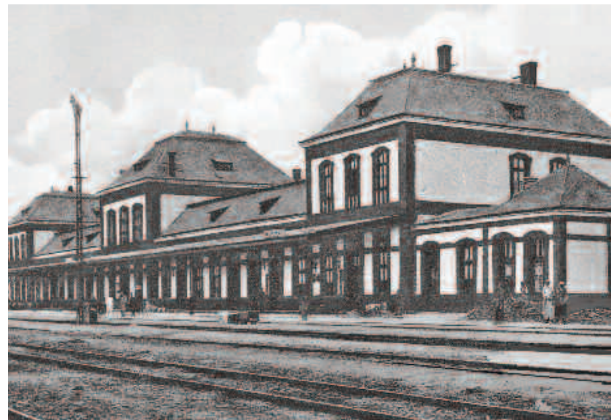
Actuala clădire a gării din Carei a fost inaugurată pe data de 24 decembrie 1912
