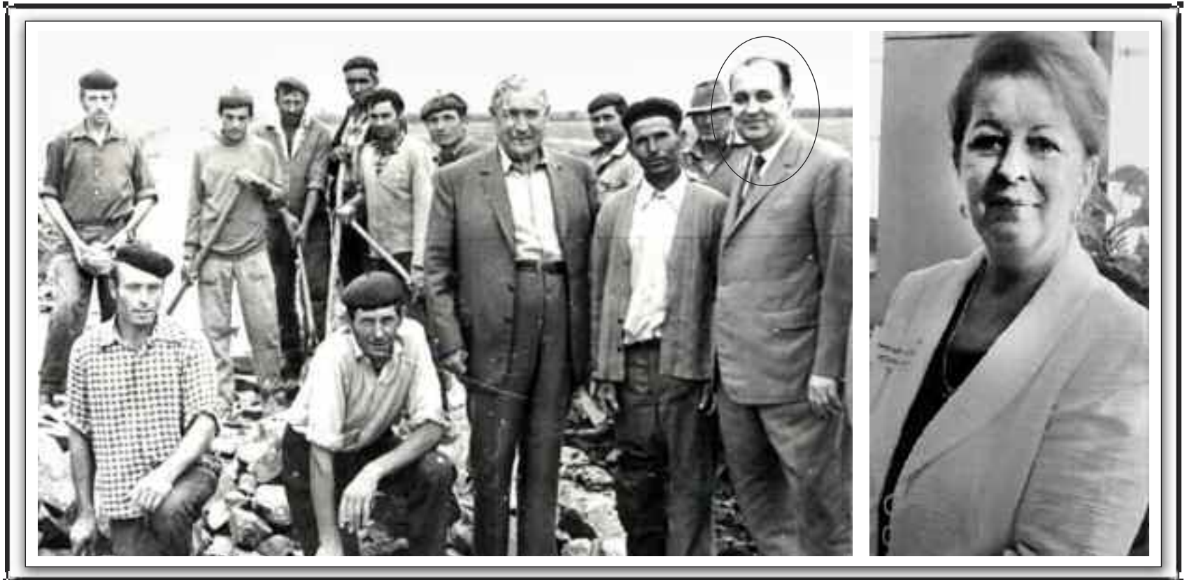
Ioan Ienciu alături de mai mulți muncitori, la reconstrucția digului după inundațiile din mai 1970
