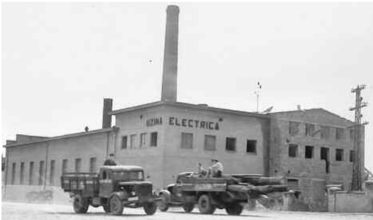
Uzina electrică a funcționat timp de 80 de ani, a fost de două ori reconstruită din temelii și a fost demolată definitiv în vara anului 1975
